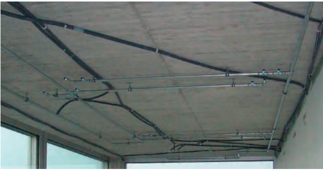
1. Installazione di tubi di dispersione dell'acqua
