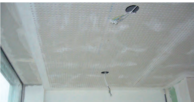
5. Riempimento e levigatura dei giunti e stampati a parete
