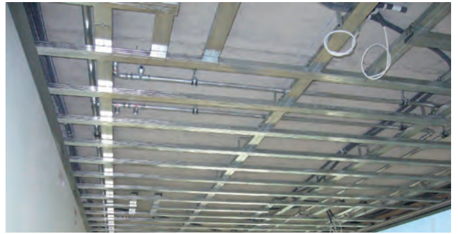
2. Installazione della sottostruttura
