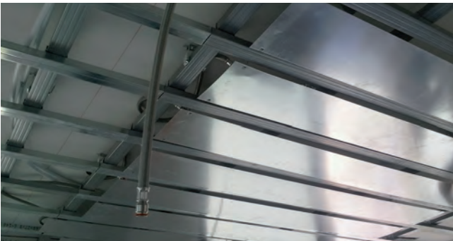
3. Installazione di elementi di refrigerazione
