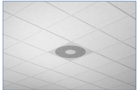
Montage dans des plafonds en T
