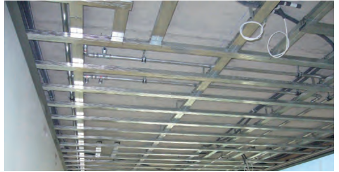
2. Montage de la substructure
