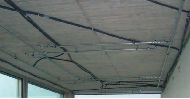
1. Montage des tuyauteries d'eau primaire
