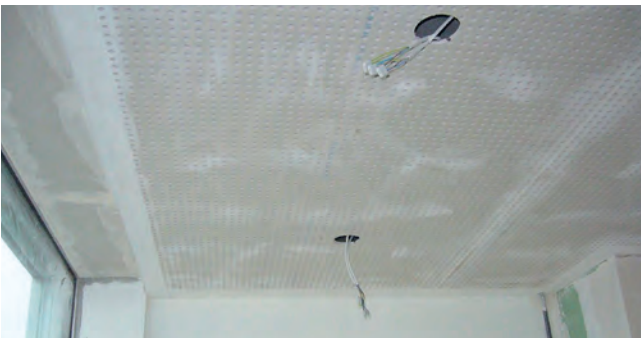
5. Comblement et ponçage des joints et des frises périphériques
