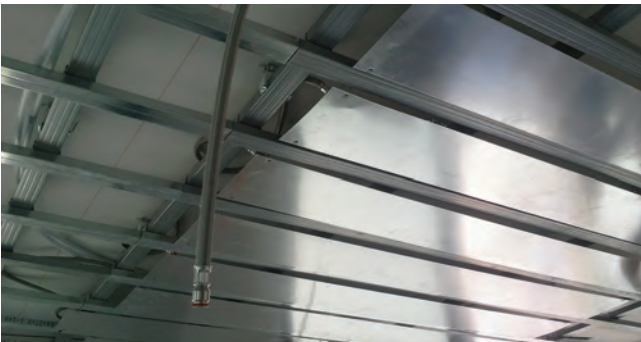
3. Montage des éléments réfrigérants
