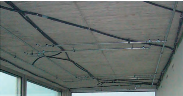
1. Montage der Wasserfeinverteilungsleitungen
