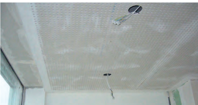
5. Spachteln und Schleifen der Fugen und Randfriesen
