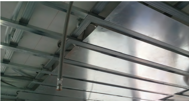
3. Montage der Kühlelemente
