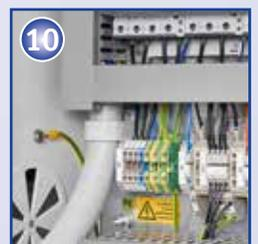
Die modular erweiterbare MSR-Lösung auf Industrie-PC-Basis kann via BACnet und Modbus mit praktisch allen Leitsystemen kommunizieren. Die Elektronik ist leicht zugänglich in einem belüfteten Schaltschrank untergebracht.
