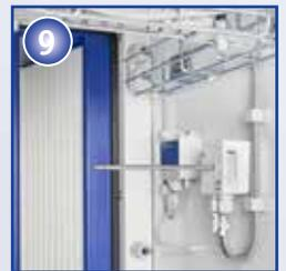
Vielfältige Sensorik zur Messung von Temperatur und Druckdifferenzen sorgt für eine bedarfsgerechte Steuerung.
