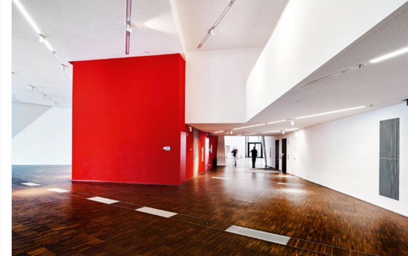
In die Bodengestaltung spielerisch integriert: die Luftgitter.
